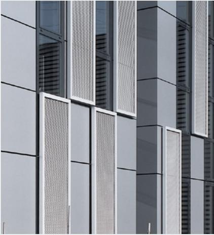
El Quadroclad es una fachada ventilada, formada por paneles compuestos por fleje de aluminio en el exterior y un alma de honey comb de aluminio en su interior. La instalación genera una cantería de 10 mm entre ellos o también cuando se intercalan con paneles de vidrio (Quadroglass).
